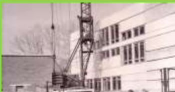
Строительство хозяйственно-бытового блока
